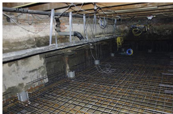
Onderkeldering in combinatie met VDM-vijzelpalen
